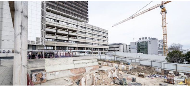
Mitte Oktober 2023 wurde für das Center for Translational Medicine die Baugrube fertig ausgehoben und die Bodenplatte gelegt.
